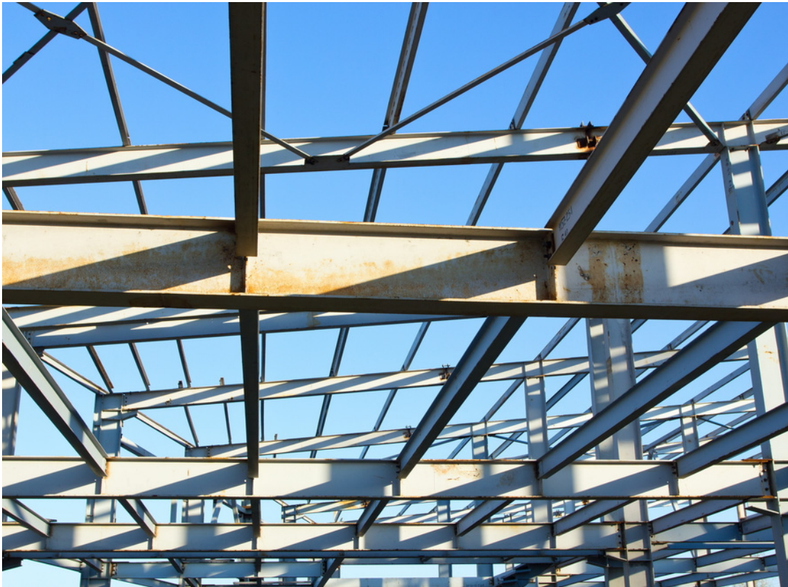
Slika 2 - Čelična konstrukcija hale
