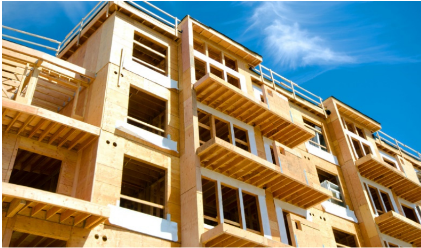
Slika 9 - Zgrada napravljena od drvene konstrukcije
